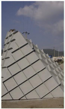
GAZ KANALI İMALATI
